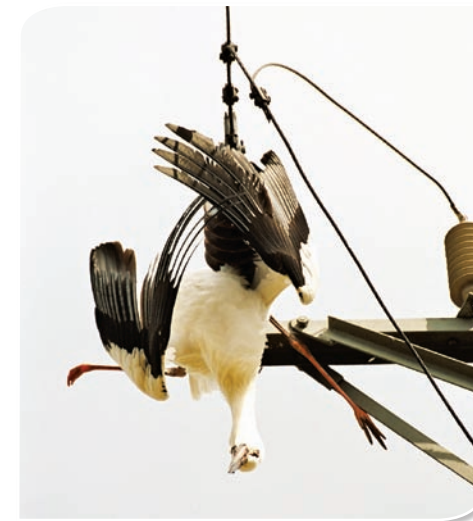
Nieodpowiednio zabezpieczony słup potrafi być przyczyną śmierci wielu bocianów. Fot. MR
