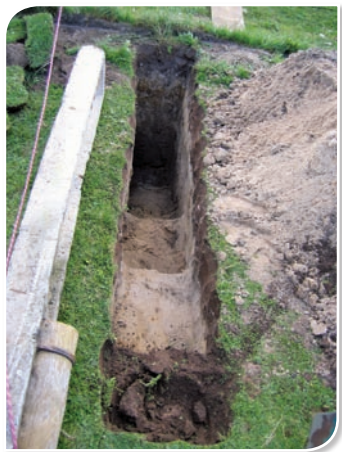
Schodkowy wykop ułatwiający ustawienie słupa. Fot. AT
